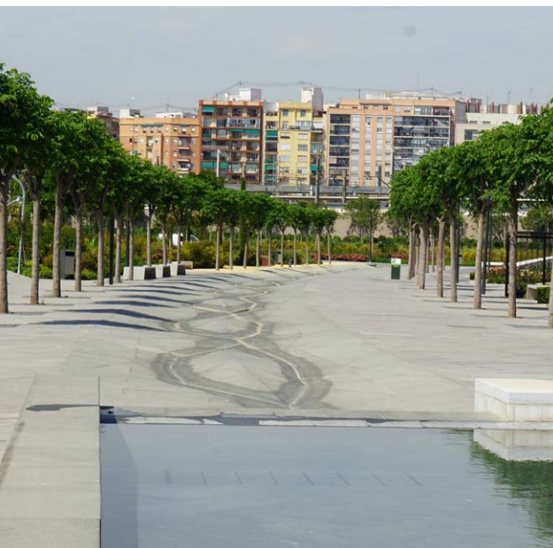
En slingrande rännedal tar hand om dagvattnet.
